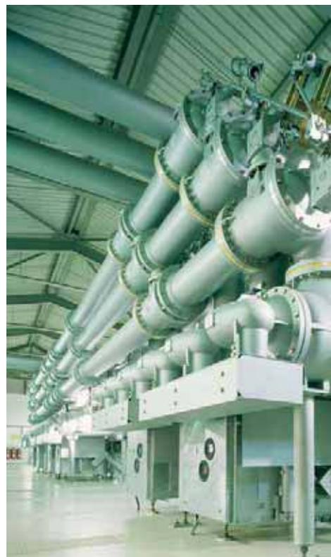
En voltajes altos o medios, se usa el  $\text{SF}_6$  para evitar contactos eléctricos. El testo 6740 controla de forma constante la humedad - de esta forma, los ciclos de intercambio del costoso gas se maximizan; se evitan daños.
