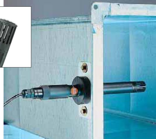
Medición de humedad en conductos HVAC
