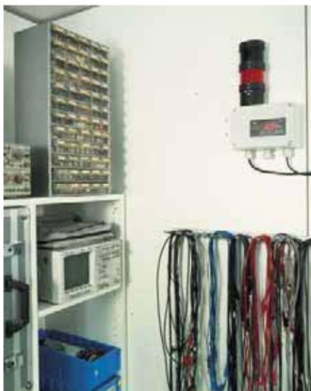
Las dos salidas relé del testo 54 permiten dos alarmas descentralizadas cuando se exceden los valores límite, p.ej. con la ayuda de la columna de alarma
