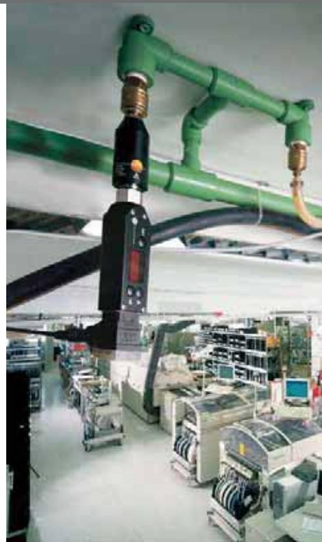
En aplicaciones críticas, el testo 6740 monitoriza la humedad del aire comprimido directamente ante el usuario - p.ej. en la producción de componentes electrónicos.
