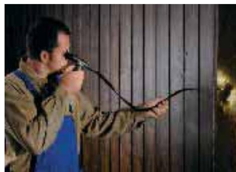
Comprobación de aislamientos mediante la estabilidad del tubo Dekabon
