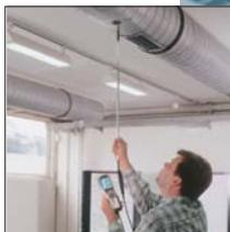
Ajuste de un sistema de ventilación
