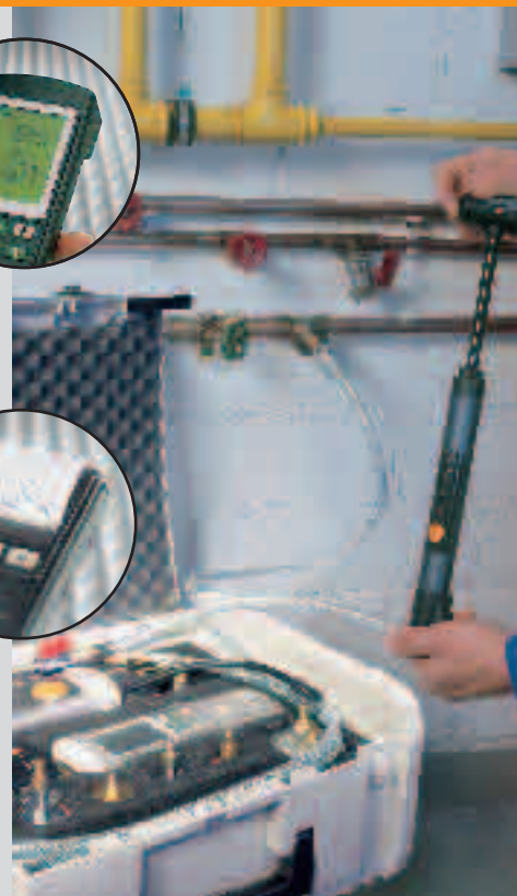
Comprobación de presión en tuberías de agua (test de presión 3-5 bar)
