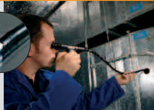
Inspecciones en conductos de ventilación, con protección maleable flexible
