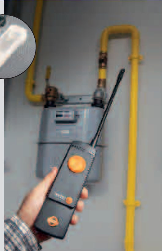
Control de fugas en tuberías domésticas de gas
