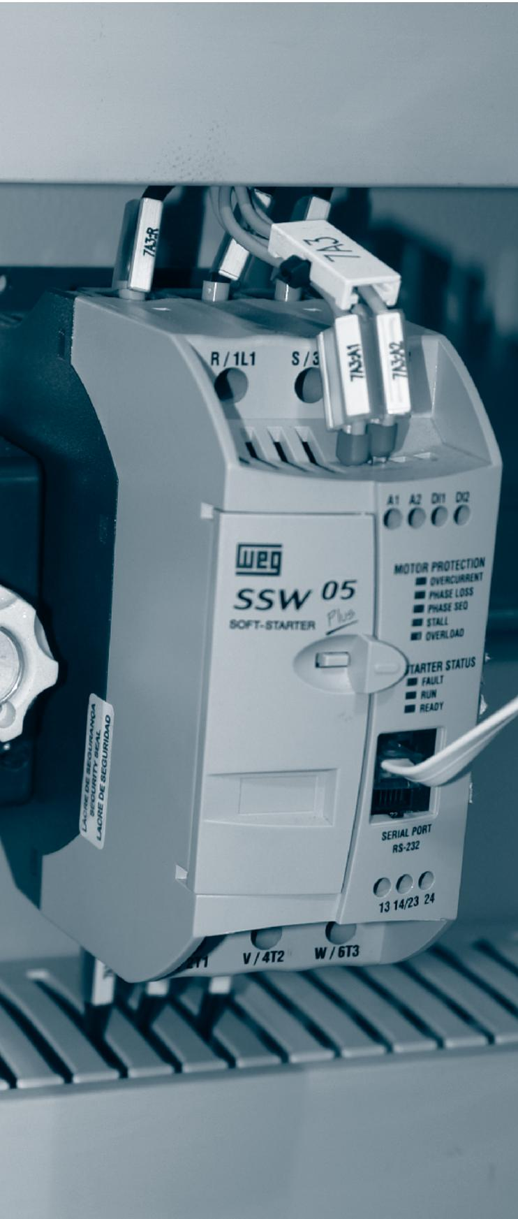
El Micro Arrancador Suave SSW-05 Plus, con control DSP (Digital Signal Processor) fue proyectado para aportar un excelente rendimiento durante los arranques/paradas de motores eléctricos con excelente beneficio/coste.
