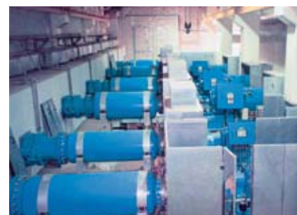
Suministro: HGF450, 630kW (845HP), 6.600V, 2 polos Aplicación: Sopladores
