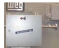
Sistema de presurización para área clasificada
