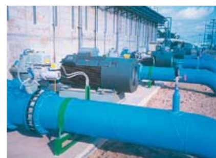
Suministro: HGF355, 290kW (390HP), 3.300V, 4 polos Aplicación: Bombas centrífugas
