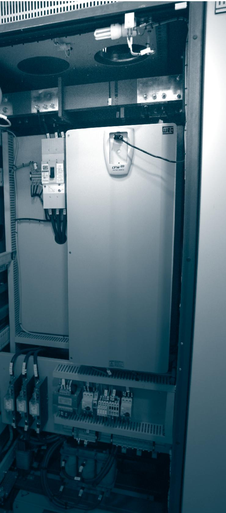
La línea de convertidores de frecuencia WEG CFW-09 incorporan la más avanzada tecnología para el accionamiento de motores eléctricos de inducción trifásicos.
