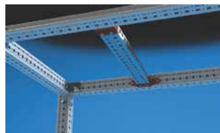
Fijación en el techo
