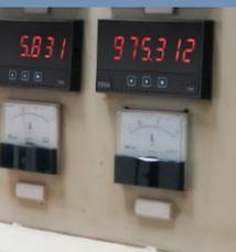
La Serie C de indicadores de panel ofrece versatilidad y fiabilidad en aplicaciones industriales, ofreciendo en **una única referencia** la posibilidad de cubrir una **amplia gama de señales analógicas de entrada**, desde corrientes y voltajes en AC y DC, termopares, sondas Pt y Ni, a sondas tipo NTC y resistencias.
